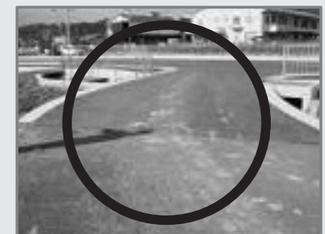
○ 泥を除去している
